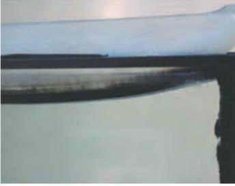
Bei der Ausführung von Traufpunktversiegelungen wird, wie auch in der Abbildung 10.25 zu sehen, neben der fehlerhaften Auswahl des Verglasungsdichtstoffes oft auch noch ein weiterer, gravierender Fehler gemacht. Hier wurde die Fugentiefe falsch dimensioniert, das heißt, sie wurde viel zu tief ausgelegt.
