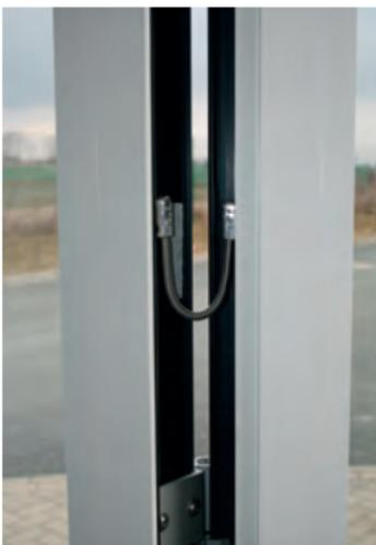
Die minimale freie Falzraumhöhe beträgt 6 mm. Bei der Rahmenkonstruktion ist für die Verlegung der Steuerkabel Folgendes zu beachten:
