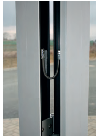
Abb. 32: Kabelführung Rahmen – Flügel
